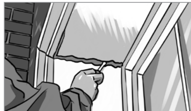
Рис. 9. Между собой фасадные элементы стыкуются посредством клея-пены
