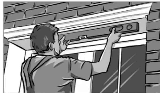
Рис. 8. Проверка правильности положения приклеенного элемента
