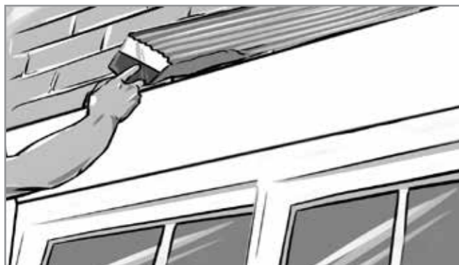
Рис. 5. Нанесение монтажного клея на несущую поверхность.
